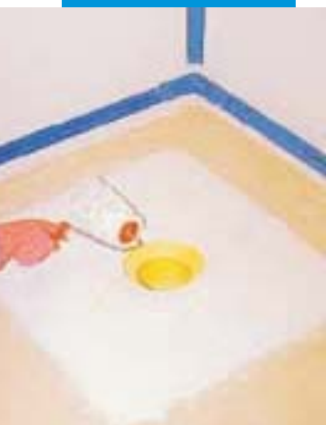
nanášení Mapegumu WPS v prostoru podlahové vpusti sprchového koutu
