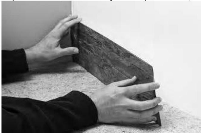
Dokud si umístěním dlaždice nejste jistí, nijak na ni netlačte, aby nedošlo k přilepení. Jakmile jste připraveni dlaždici přilepit, přitlačte ji na podklad po celé její ploše a přidržte po dobu několika sekund.
