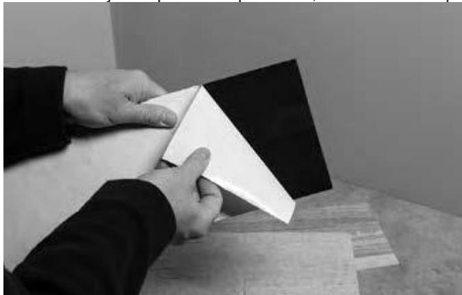
2) Dlaždici přikládejte k podkladu horní části odkloněnou od podkladu tak, aby se dlaždice nenalepila na podklad dříve, než budete vyžadovat (viz. obrázek).
