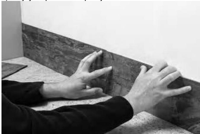
4) Při zahájení aplikace dlaždic na druhou řadu je třeba uložit dlažbu zpátky asi o 30 stupňů, položit dolní okraj dlaždice dolů a pak ji posunout, aby se zkopírovala předchozí dlaždice.
