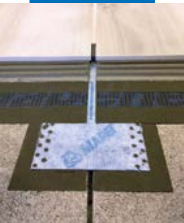
Mapeband Easy instalovaný v linii kontrolní dilatační spáry v potěru
