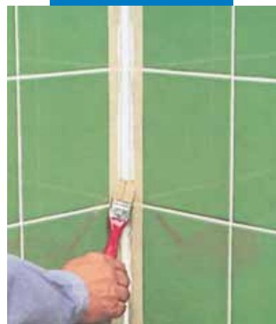
Vyhrazení povrchu spáry saponátovým roztokem a štětcem
