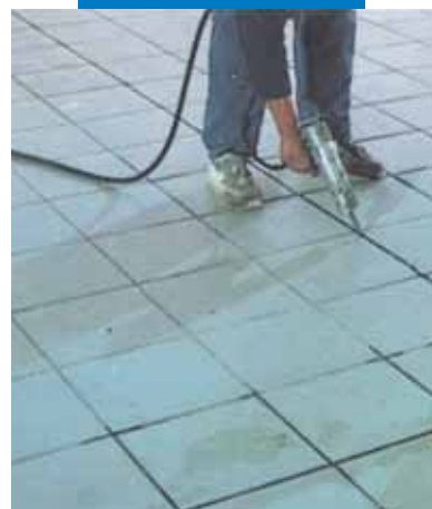
Těsnění spáry Mapesilem AC v keramické dlažbě
