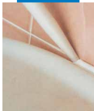
Těsnění spáry u sanitárních předmětů
